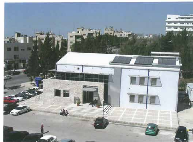
ترميم مبنى النشاطات الطلابية لكي يصبح المبنى المؤقت لمكتبة الحسن ٢٠٠٤
